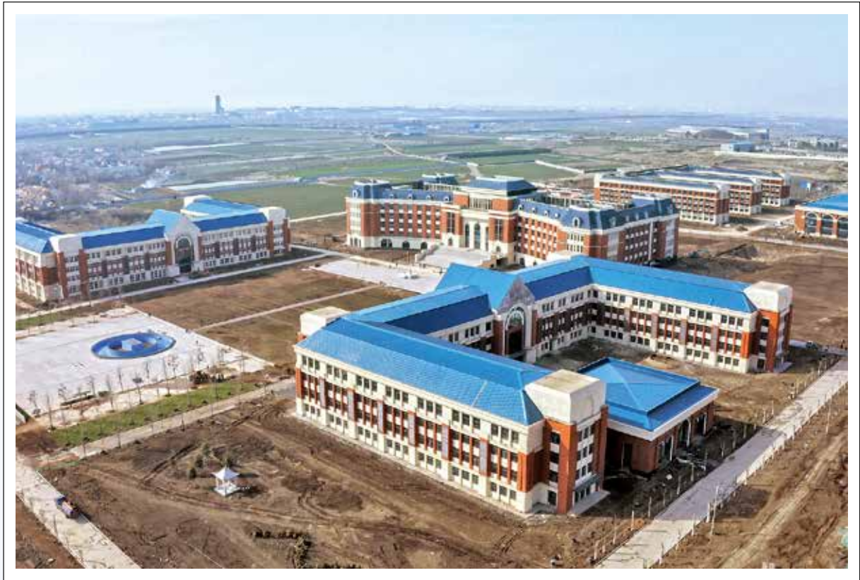
山东食品科技职业学院在建项目
